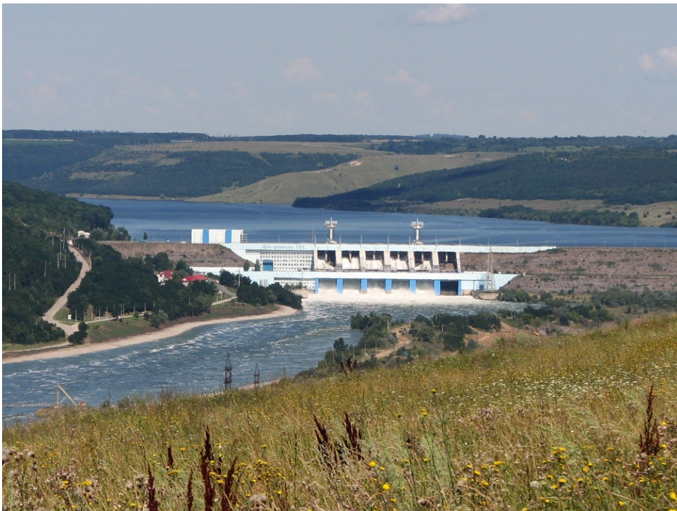
Рисунок 1.3 – Вид на Дністровську ГЕС
