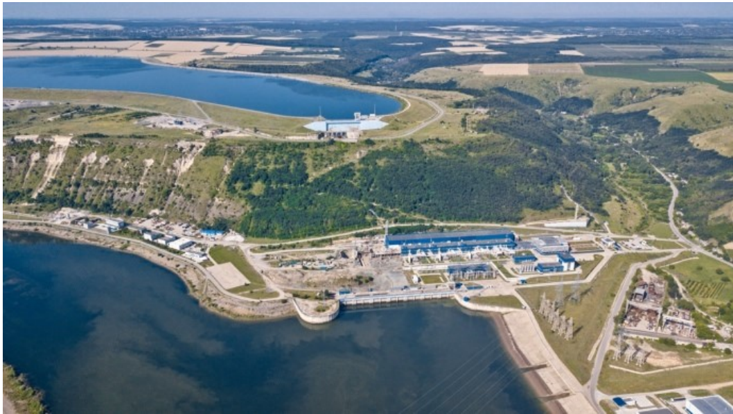
Рисунок 1.4 – Вид на Дністровську ГАЕС
