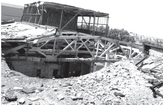
Рис. 2. Фото зони повного руйнування покриття внаслідок влучання ракети
