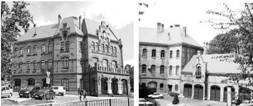
Рис. 1. Фасад триповерхового комплексу пожежної частини по вул. Підвальна 6
