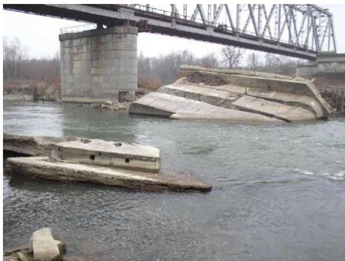
Рис. 3.6. Сучасний залізничний міст і залишки старого (зруйнованого внаслідок паводку 1969 року) на р. Прут у м. Чернівці
