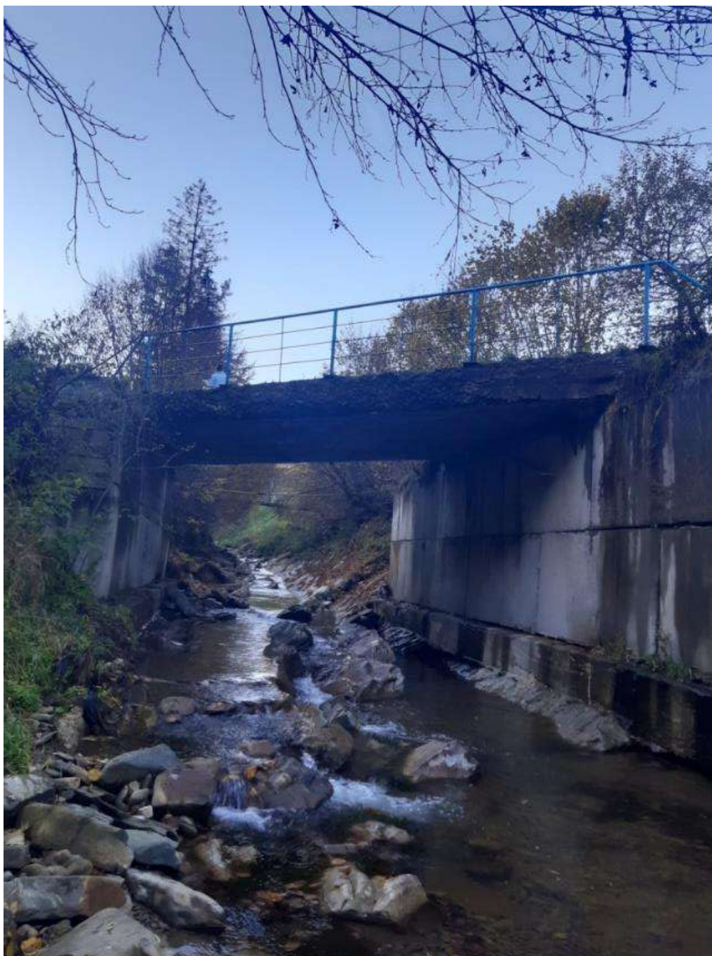
Рис. 3.8. Точка №4, автомобільний міст (фото автора 01.11. 2020)
