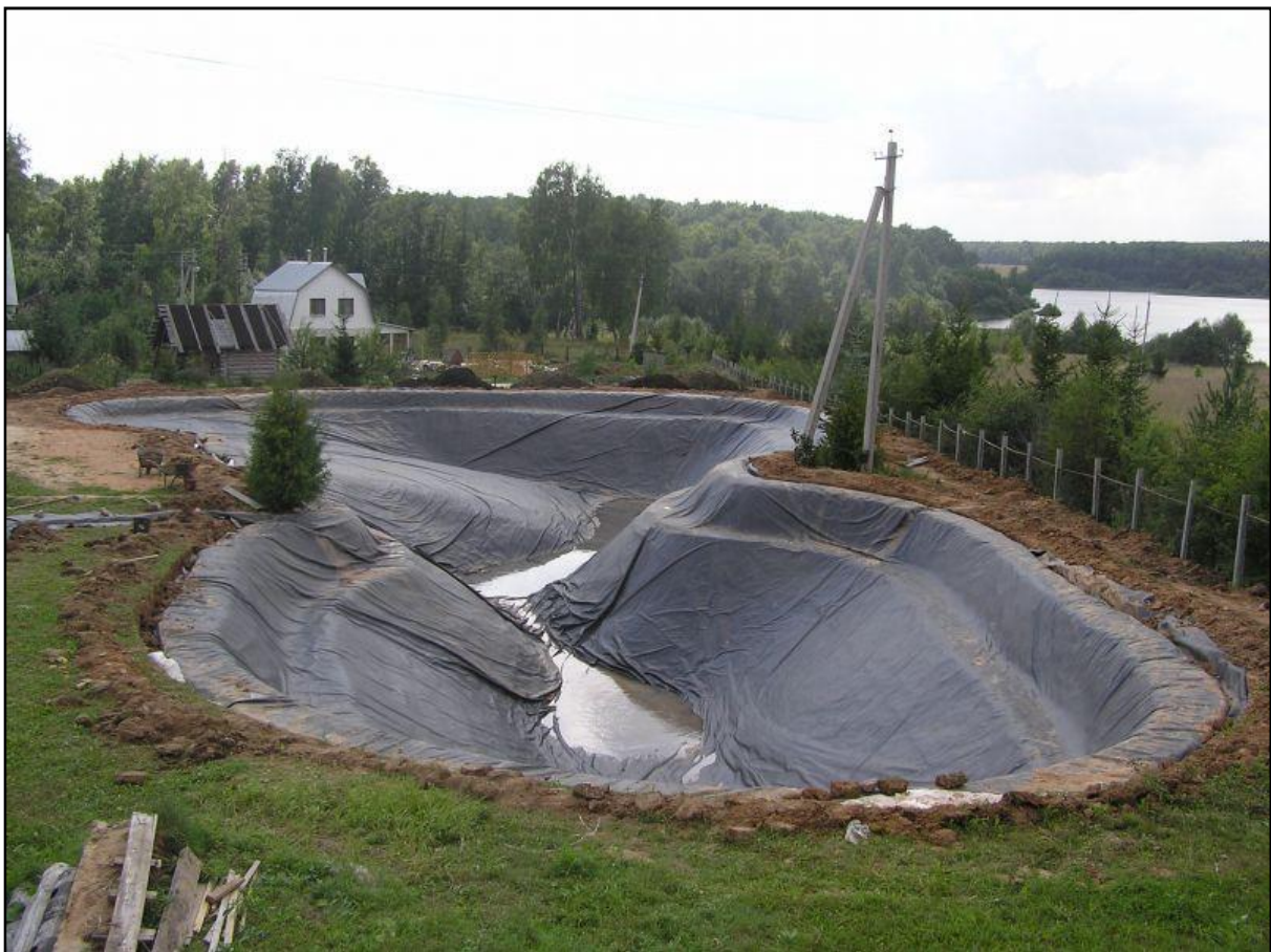
Рис. 46. Приклад облаштування дна штучної водойми з метою мінімізації втрат води
