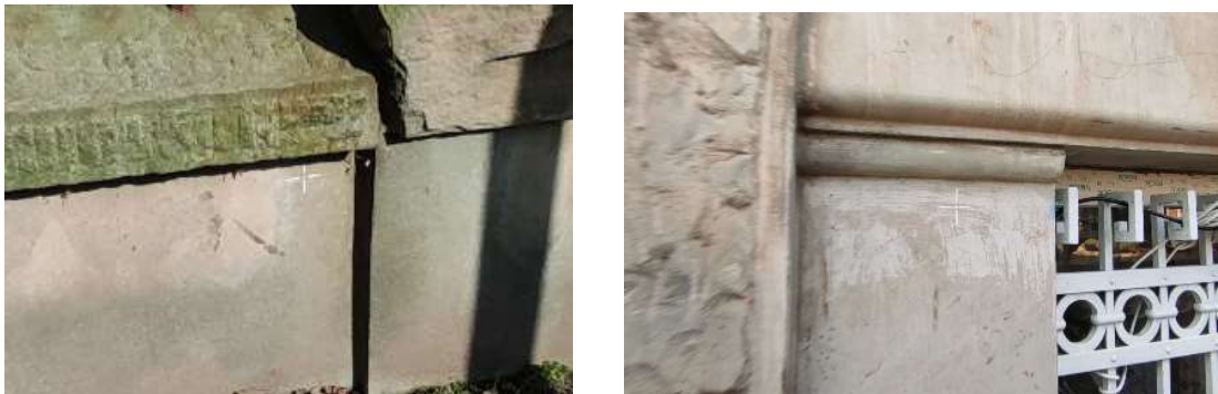
Рис. 1.1. Приклад настінної марки геодезичної основи будівельного майданчика
