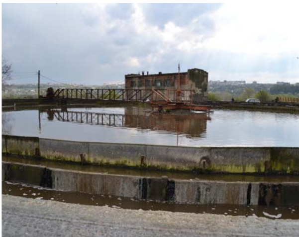
Рис. 6.10 Радіальний відстійник
