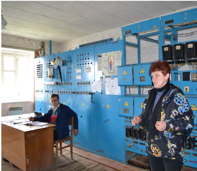
Рис. 5.8. Щит керування роботою водозабору «Митків»
