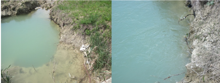
Рис. 5.24. Витoki у районах, де труби проходять під землею після труб на опорах
