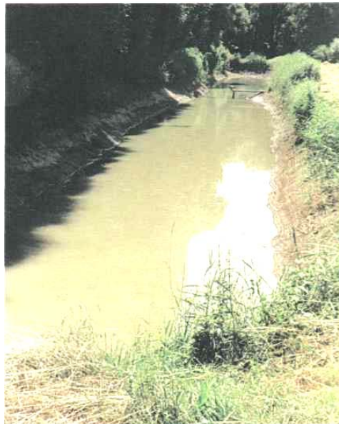
Рис. 3.3. Басейн інфільтрації станції Магала
