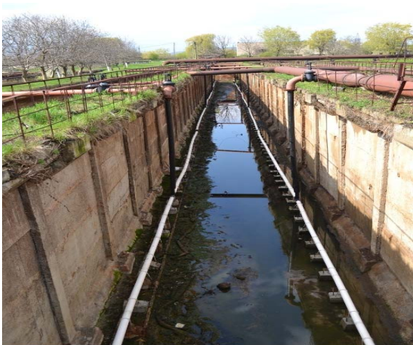
Рис. 6.12. Система аерації в аеротенках
