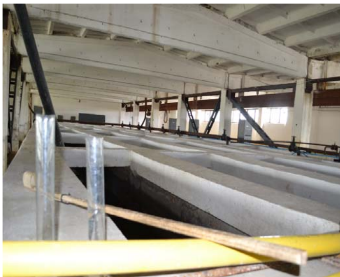
Рис. 5.17. Горизонтальні камери флокуляції
