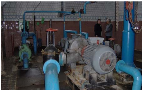
Рис. 5.37. Насосна станція «Рогізна» II підйому
