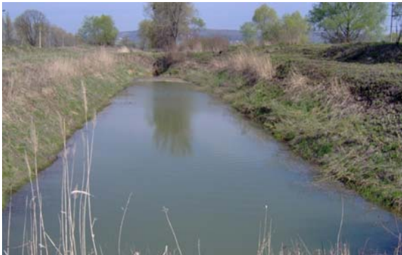
Рис. 5.32. Басейн-відстійник на водозаборі «Магала»
