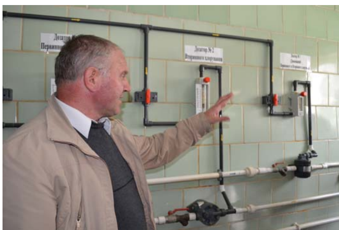
Рис. 5.14. Система первинного і вторинного хлорування з лічильниками
