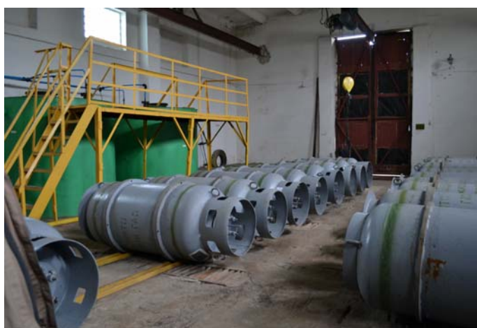
Рис. 5.11. Склад хлорування з бочками хлору і краном
