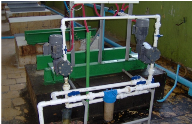
Рис. 5.16. Насоси для дозування Polvak 40
