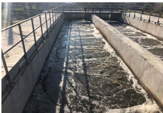
Рис. 6.8. Горизонтальний піскоуловлювач
