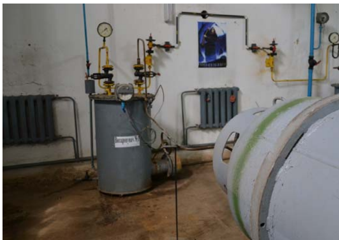
Рис. 5.13. Випаровувач на складі хлору
