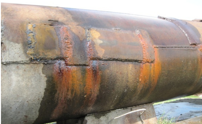
Рис. 5.23. Наварювання металевих пластин на водогін
