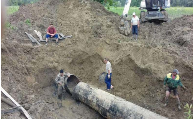
Рис. 5.21. Ремонт водогону
