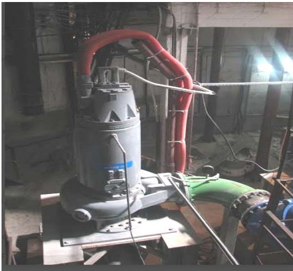
Рис. 6.2. Насосний агрегат на КНС «Садгірська»
