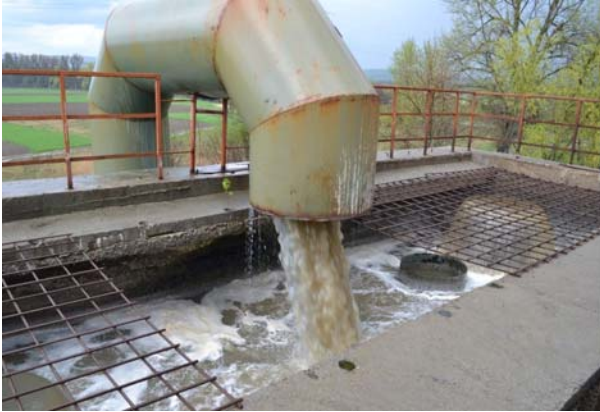
Рис.6.5. Приймальна камера
