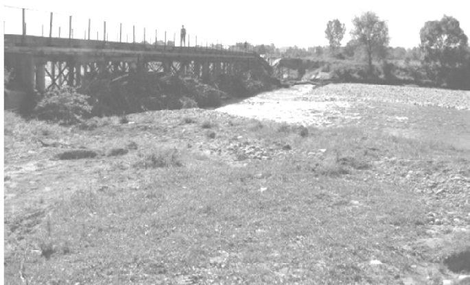
Рис. 2.14. Частково зруйнований міст через р. Чечву біля с. Довга Калуська (Видно велику кількість «деревного наносу» та гребінь гряди, що зупинилася і частково розмита перед мостом)
