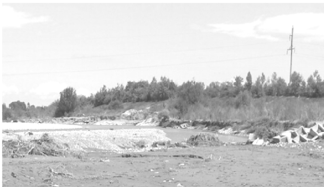
Рис. 2.11. Розмив дамби обвалування на правому березі р. Бистриця Надвірнянська вище с. Черніїв (на другому плані видно більш потужну дамбу обвалування ставка)
