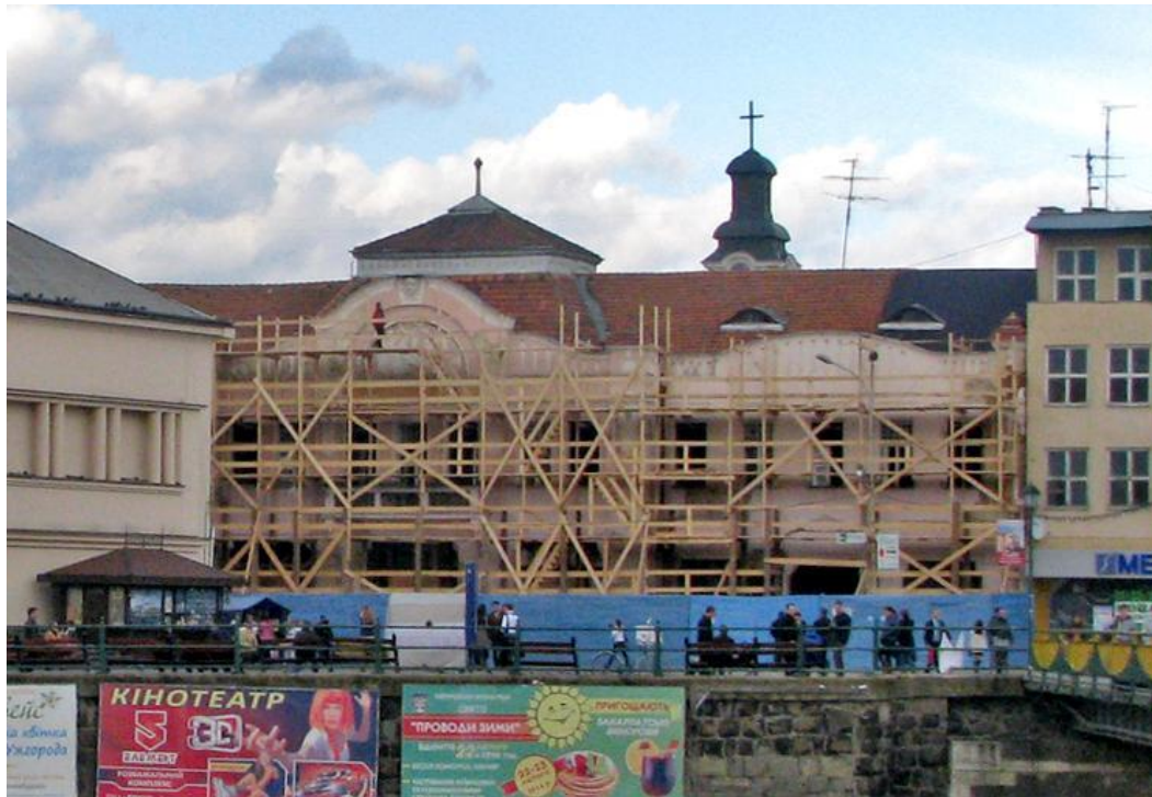
Мал. 3.4. Початок реконструкції приміщення готелю «Корона» [31]
