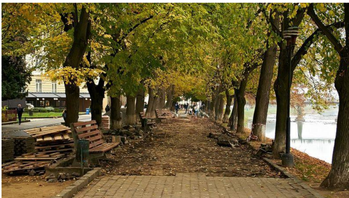
Мал. 3.21. Набережна Незалежності під час реконструкції [64]
