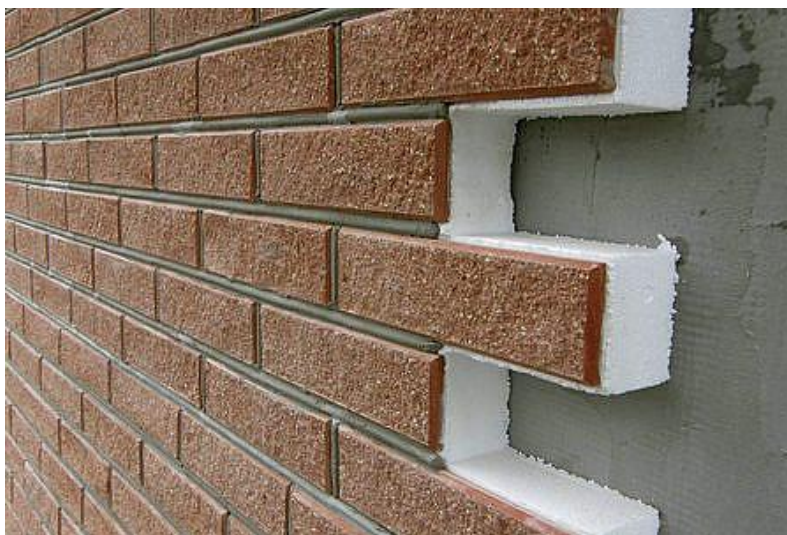
Рис 1 – Використання пінопласту під час модернізації будівель
