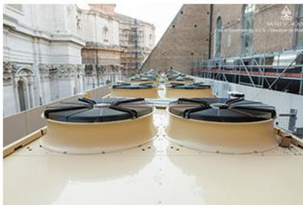
Іл.2 Система кондиціонування Сикстинської капели Опубліковано на сайті ( https://www.ahi-carrier.com/keeping-history-cool/ )
