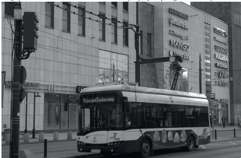
Fotografia 2. Ładowarka do ładowania autobusów elektrycznych przez pantograf na ul. Pawiej w Krakowie
