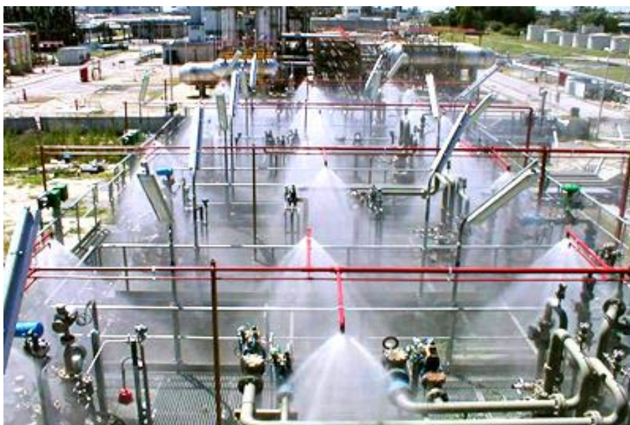
Рис. 5.25. Види стаціонарних установок пожежогасіння А – спринклерні; Б – дренчерні.
