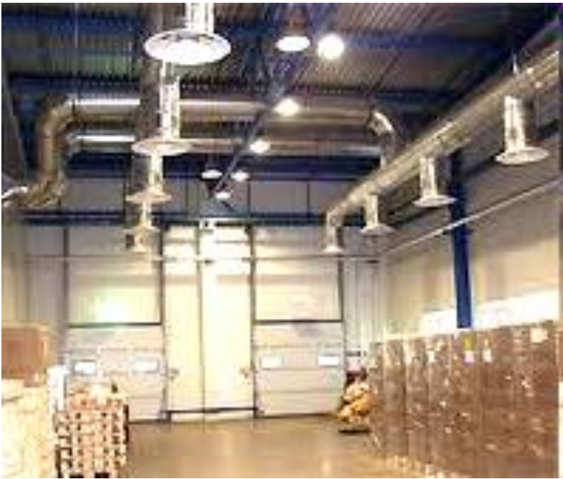
Рис. 5.13. Приклади оформлення локальної вентиляції.
