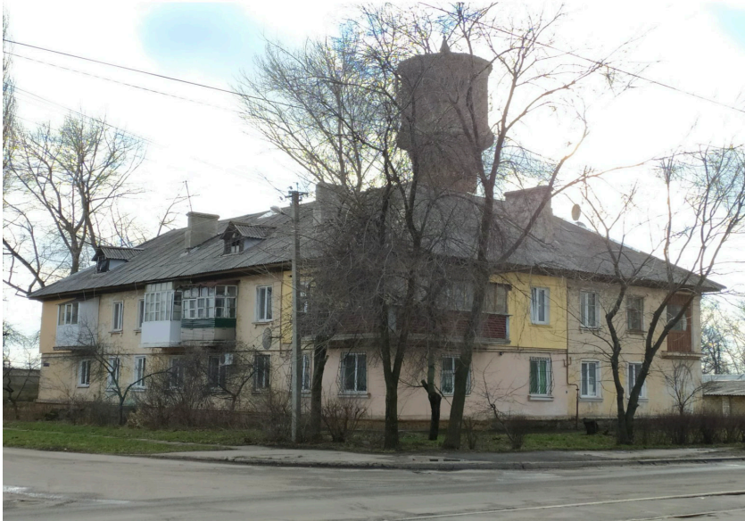
Abb. 3: Chemiker Straße, 22, Kamjanske. Ein typisches Gebäude, das von deutschen und japanischen Kriegsgefangenen gebaut wurde.
