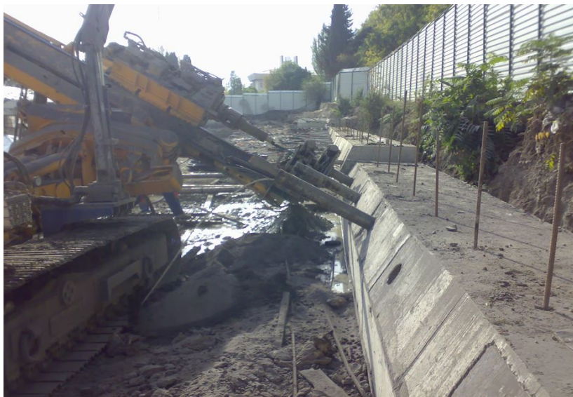
Рис.4.2 Влаштування підпірної стінки, яка укріплена анкерами (м. Алушта).
