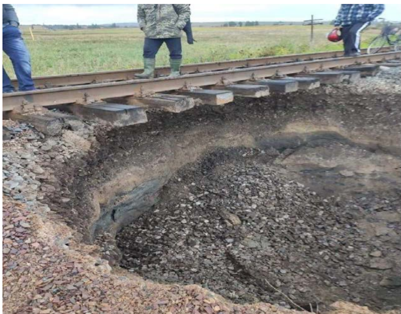
Рисунок 1.3. Карстовий провал на перегоні Новоселиця-Мамалига(жовтень 2021 р.)
