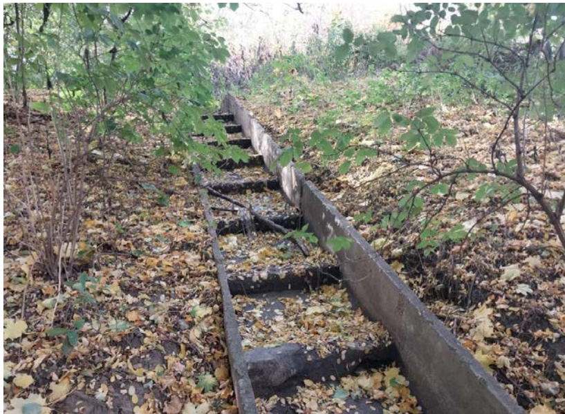
Рис.4.5. Швидкоток у складі протизсувних споруд (м. Чернівці, мікрорайон Руський, 2023 р.)
