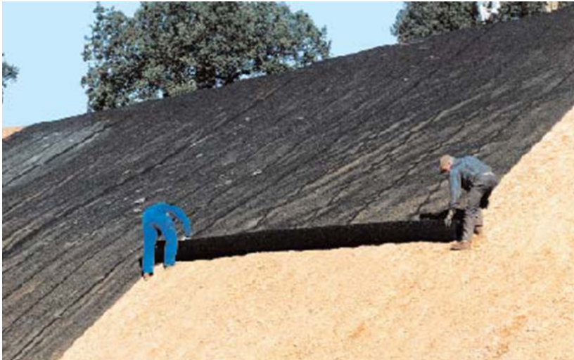
Рис.4.11. Укладання геомату для закріплення укосу.
