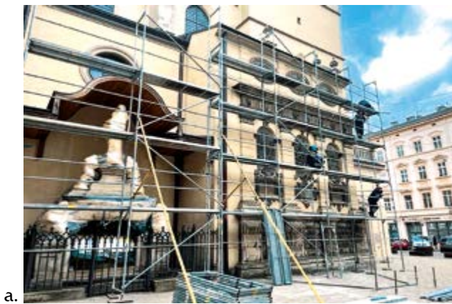
Рис. 8.16. Виконання РРР по фасадах, м. Львів: а) монтаж інвентарної риштовки; б) виконання робіт з захисту вітражів за допомогою телескопічної вишки (2022)
