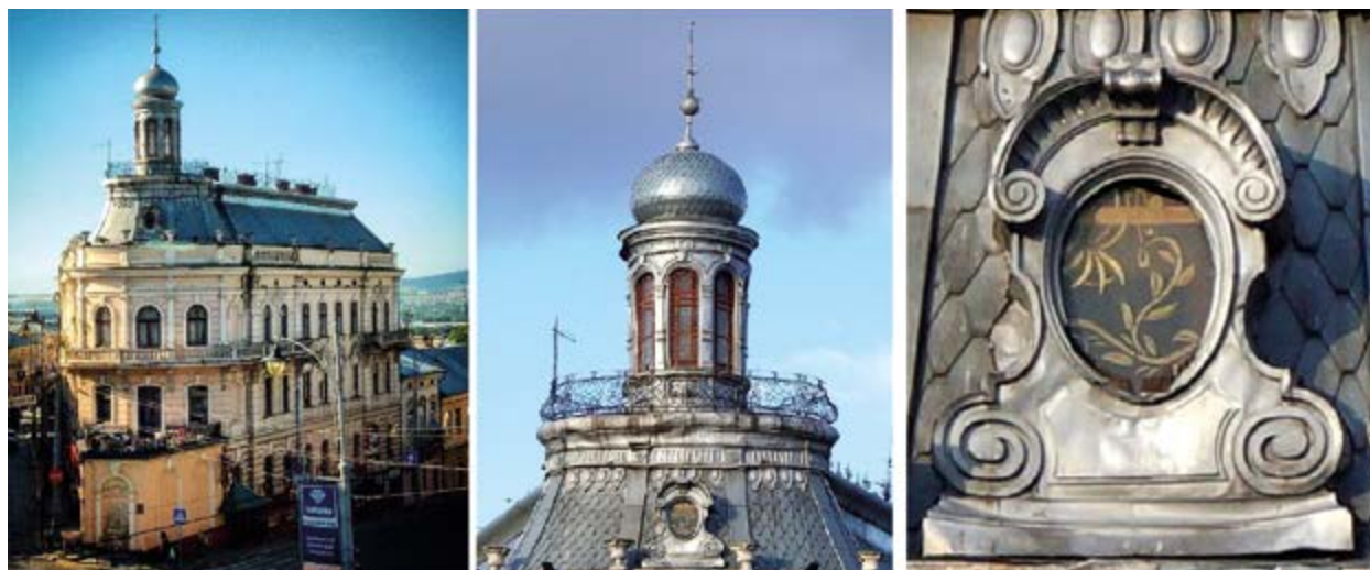
Рис. 8.51. Бляшана покрівля житлового будинку, м. Чернівці, вул. Головна, 25 (фото В. Горбоносов)
