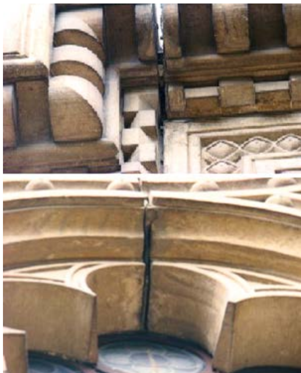
Рис. 8.4. Деформація типу «злам» вімпергу входу та масверку Семінарської церкви Трьох Святителів Резиденції митрополитів Буковини і Далмації, Чернівці, через зволоження і просідання ґрунту по кутах споруди (фото І.Коротун, 2015)
