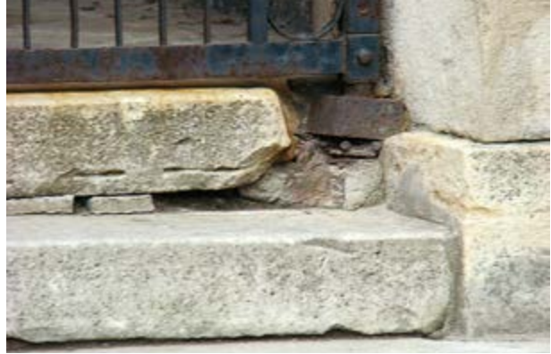
Рис. 8.34. Руйнування (розривання тіла каменю) вапняку від контакту із залізним кріпленням воріт. Галерея Семінарського корпусу Резиденції митрополитів Буковини і Далмації (фото І. Коротун, 2015)
