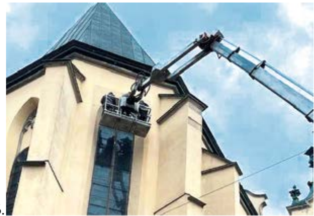
Рис. 8.16. Виконання РРР по фасадах, м. Львів: а) монтаж інвентарної риштовки; б) виконання робіт з захисту вітражів за допомогою телескопічної вишки (2022)
