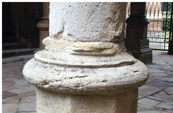
8.33. Структурне руйнування поверхні баз колон з вапняку внаслідок атмосферних впливів. Галерея Семінарського корпусу Резиденції митрополитів Буковини і Далмації (фото І. Коротун, 2015)
