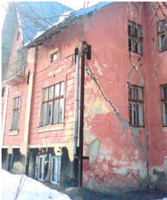
Рис. 8.6. Відсутність водостічних труб на фасаді призвела до системного замокання та просідання ґрунту, що довело споруду до аварійного стану. Чернівці, вул. Федьковича, 29 (фото І. Коротун, 2017)
