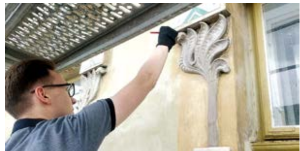
Рис. 8.26. Розчистка елементів флорального декору при проведенні РРР, на фасаді будинку колишнього страхового товариства «Дністер», вул. Руська, 20, м. Львів (фото Г. Корнєєв, 2021 р.)
