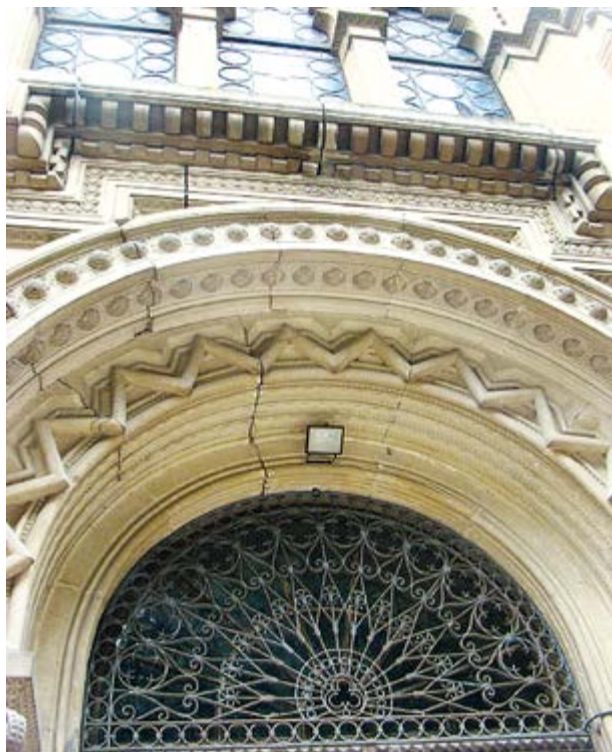
Рис. 8.4. Деформація типу «злам» вімпергу входу та масверку Семінарської церкви Трьох Святителів Резиденції митрополитів Буковини і Далмації, Чернівці, через зволоження і просідання ґрунту по кутах споруди (фото І.Коротун, 2015)
