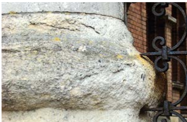
8.33. Структурне руйнування поверхні баз колон з вапняку внаслідок атмосферних впливів. Галерея Семінарського корпусу Резиденції митрополитів Буковини і Далмації (фото І. Коротун, 2015)
