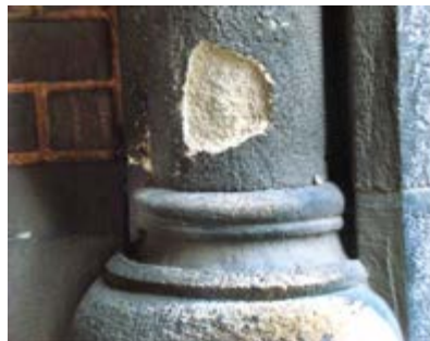
Рис. 8.35. Структурні зміни і руйнація поверхонь вапняку «дика патина». Галерея Семінарського корпусу Резиденції митрополитів Буковини і Далмації (фото І. Коротун, 2015)
