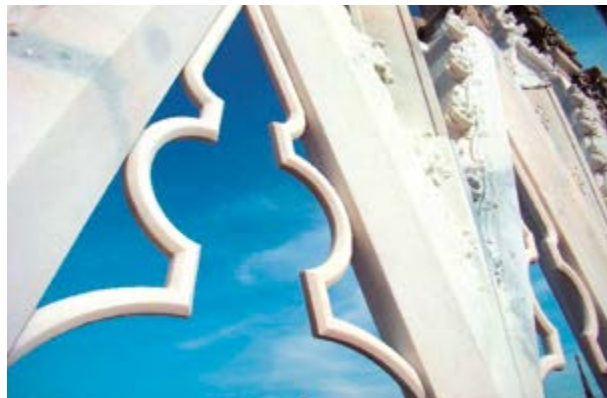
Рис. 8.32. Процес реставрації мармуру від поверхневого забруднення, Мілан, кафедральний собор Різдва Пресвятої Діви Марії: а) аркатура даху собору, світлі ділянки – розчищений мармур; б) фрагмент завершеної реставрації аркатури (фото І. Коротун, 2011)
