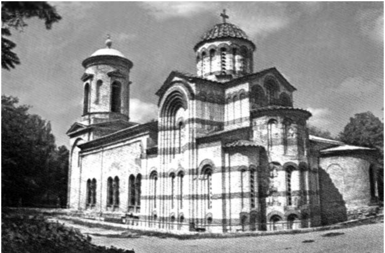
Рис. 5.5. Реставрація церкви Іоанна Предтечі у Керчі. Вигляд храму до реставрації та після реставрації, 1990.
