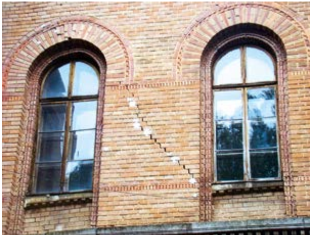
Рис. 8.7. Деформація зовнішніх стін галереї Семінарського корпусу Резиденції митрополитів Буковини і Далмації через нерівномірне просідання фундаментів (фото І. Коротун, 2017)
