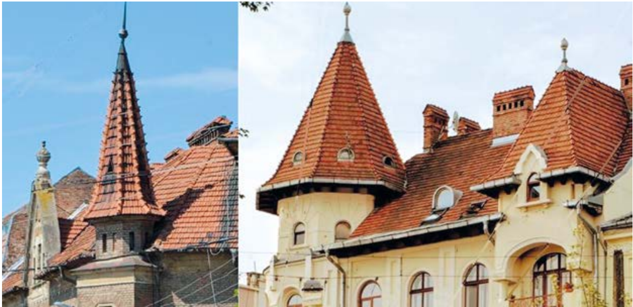
Рис. 8.49. Покрівля з пазової черепиці на дахах житлових будинків першої третини ХХст., Чернівці, вул. Лесі Українки, 14; Університетська, 15 (фото І. Коротун, 2022).
