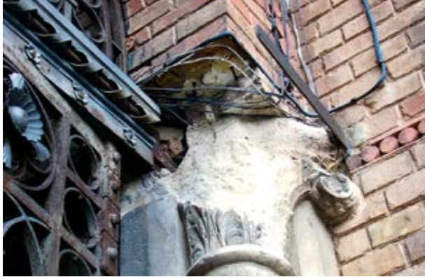
Рис. 8.34. Руйнування (розривання тіла каменю) вапняку від контакту із залізним кріпленням воріт. Галерея Семінарського корпусу Резиденції митрополитів Буковини і Далмації (фото І. Коротун, 2015)
