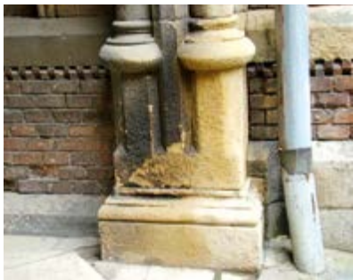
Рис. 8.35. Структурні зміни і руйнація поверхонь вапняку «дика патина». Галерея Семінарського корпусу Резиденції митрополитів Буковини і Далмації (фото І. Коротун, 2015)
