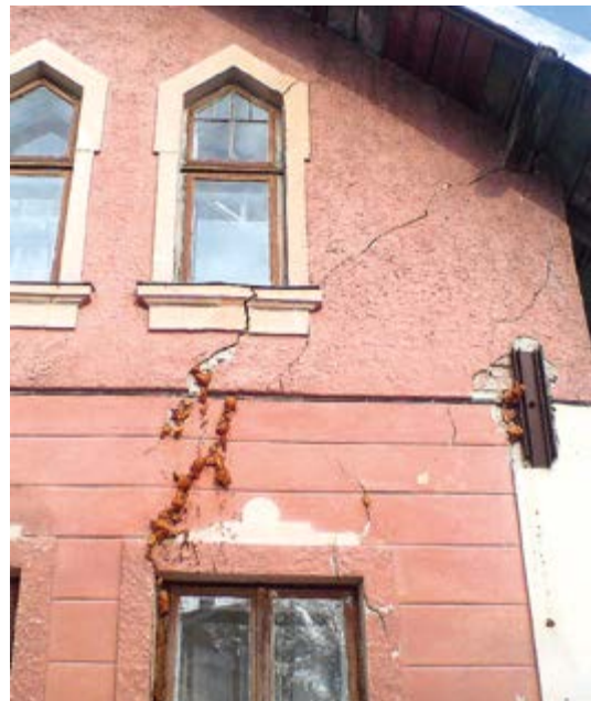
Рис. 8.6. Відсутність водостічних труб на фасаді призвела до системного замокання та просідання ґрунту, що довело споруду до аварійного стану. Чернівці, вул. Федьковича, 29 (фото І. Коротун, 2017)
