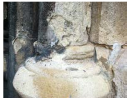
Рис. 8.35. Структурні зміни і руйнація поверхонь вапняку «дика патина». Галерея Семінарського корпусу Резиденції митрополитів Буковини і Далмації (фото І. Коротун, 2015)
