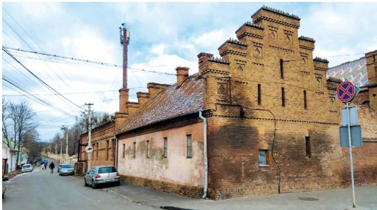
Рис. 8.41. Забруднення і зволоження мурування – допоміжна споруда Резиденції митрополитів Буковини і Далмації (фото І. Коротун, 2019)
